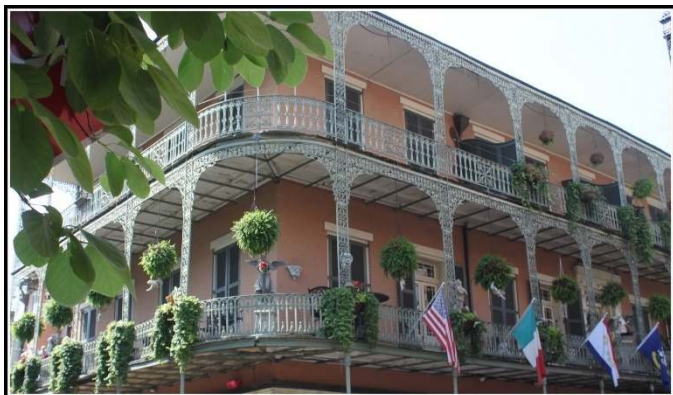
Eisengitterbrüstungen in der Royal Street/ New Orleans
